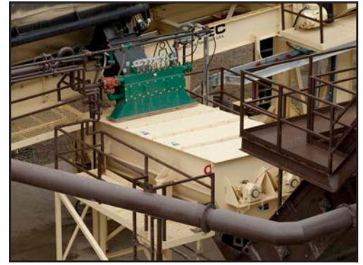
Les agrégats vierges et les RAP sont déchargés dans un malaxeur-enrobeur à hélice à deux arbres.
